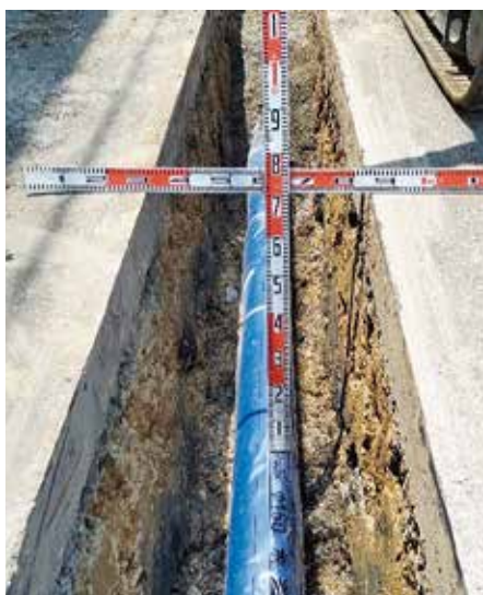
ポリエチレン管布設現場
