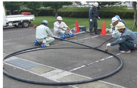
(イ) 応急給水支援設備……県送水管の空気弁設置箇所から学校、避難所などへ仮設配管を設置し、仮設給水栓より応急給水ができるようにするものです。
