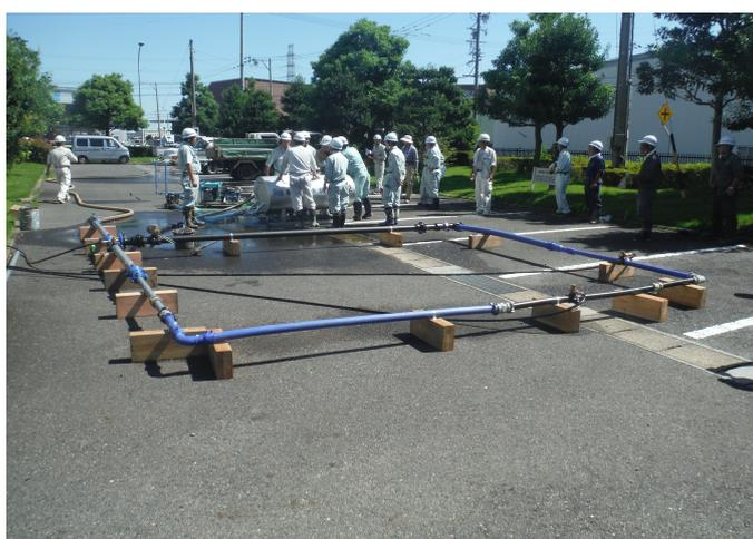
(イ) 応急給水支援設備………県送水管の空気弁設置箇所から学校、避難所などへ仮設配管を設置し、仮設給水栓より応急給水ができるようにするものです。
